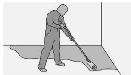
Рис. 20. Грунтование стяжки.
